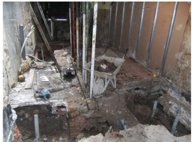
FOTO 4. Vista general dels sondejos efectuats en la fase 1
