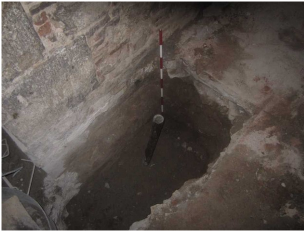
FOTO 11. Detall dels sondejos de la fase 2
