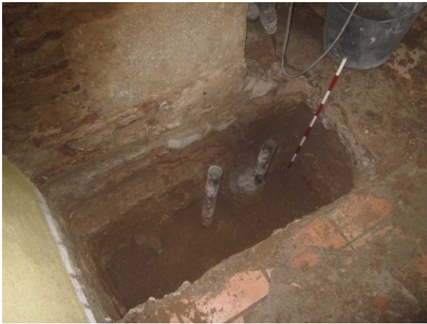
FOTO 9. Detall dels sondejos de la fase 2
