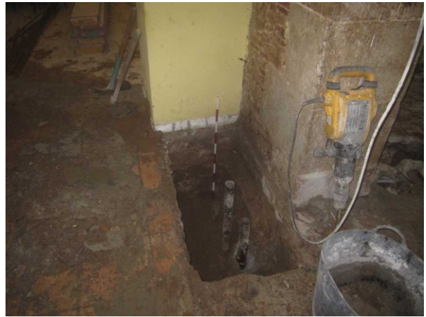
FOTO 12. Detall dels sondejos de la fase 2
