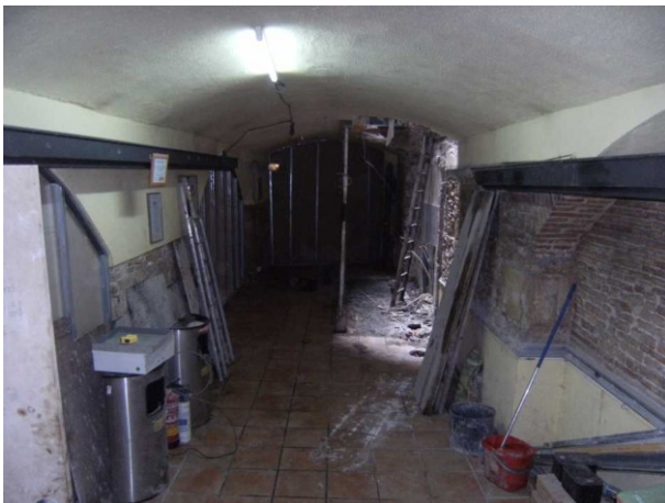
FOTO 3. Situació inicial de la part sud de l'immoble en la fase 1
