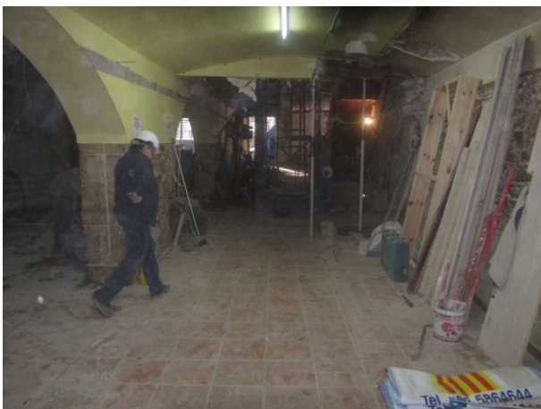
FOTO 7. Vista general de la part nord de l'immoble en la fase 2
