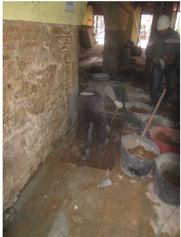
FOTO 8. Detall de les tasques d'excavació dels sondejors
