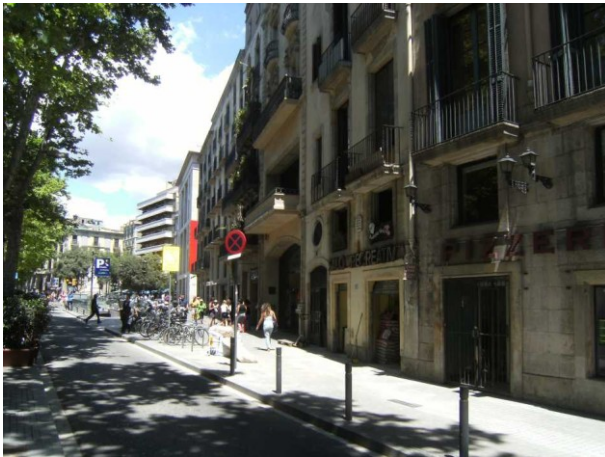
FOTO 1. Vista des del sud de l'immoble objecte d'intervenció
