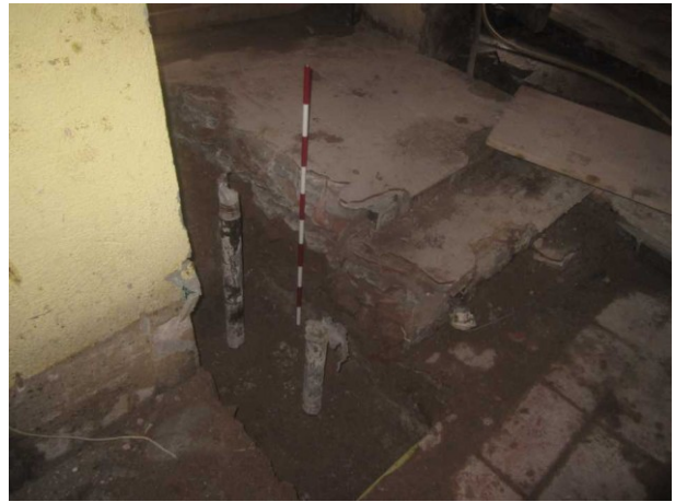
FOTO 10. Detall dels sondejos de la fase 2
